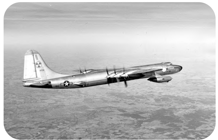
Figura 7: El Convair NB-36H en vuelo propulsado por los motores de hélice. Se puede observar debajo del ala derecha una de las turbinas nucleares que sale hacia adelante del ala por la parte de abajo.
