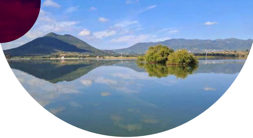
Figura 4. Imagen Panorámicode la Presa Santa Catarina.
